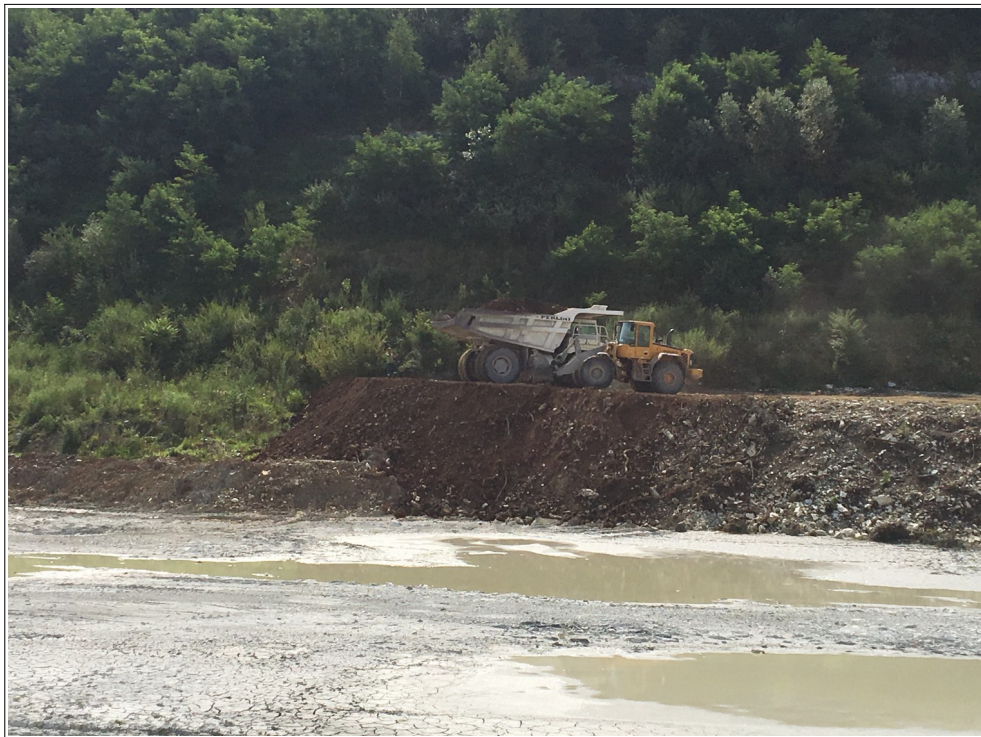
Figura 17 – Vista della fase di recupero morfologico messa in campo con il dumper che trasporta lo sterile di copertura e la pala gommata che lo distende (immagine del 03.07.2019).
