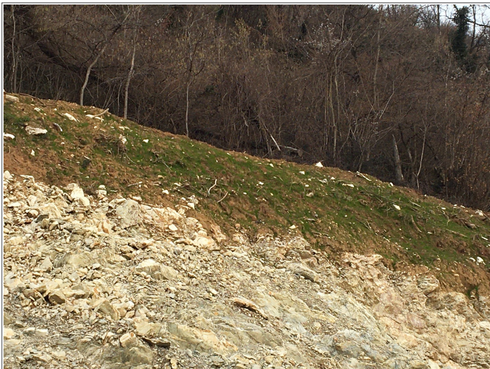
Figura 15 - Vista di una delle porzioni rinverdite con idrosemina durante l'autunno 2019 (immagine del 07.01.2020).
