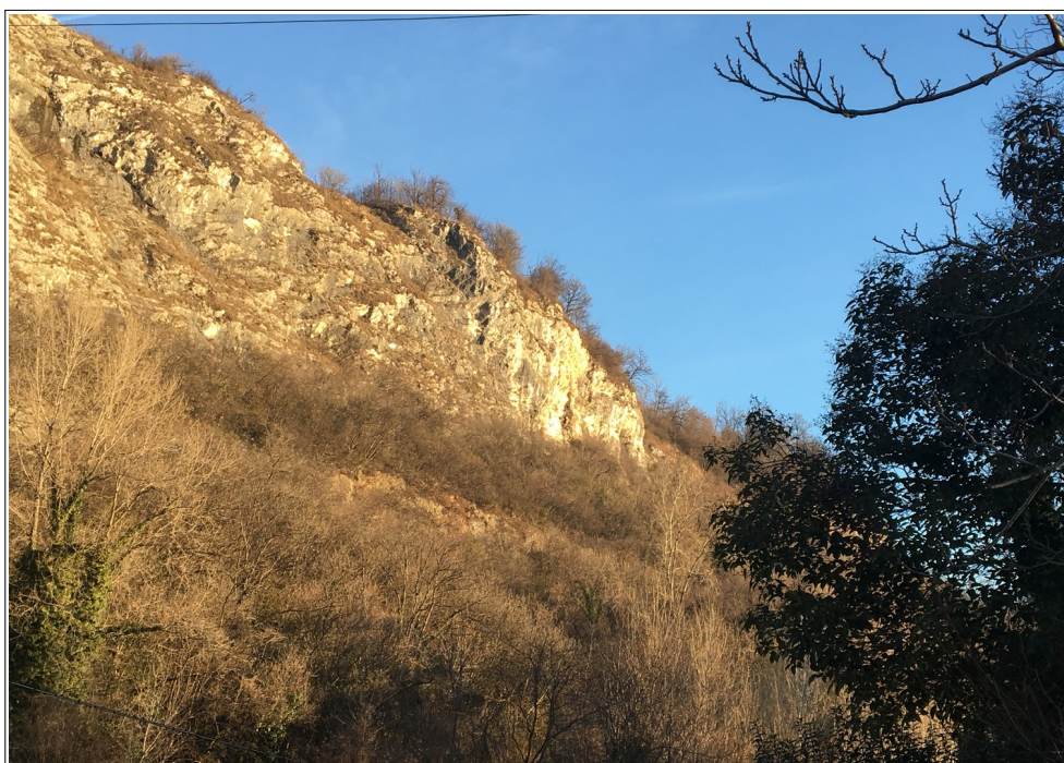
Figura 24 – Vista della medesima area rappresentata nella figura 19 dalla quale si sarebbero staccati i massi secondo la segnalazione pervenuta al Comune di Caravate nell'estate 2017, ripresa dal piazzale antistante la Chiesa parrocchiale (foto del giorno 08.02.2019).
