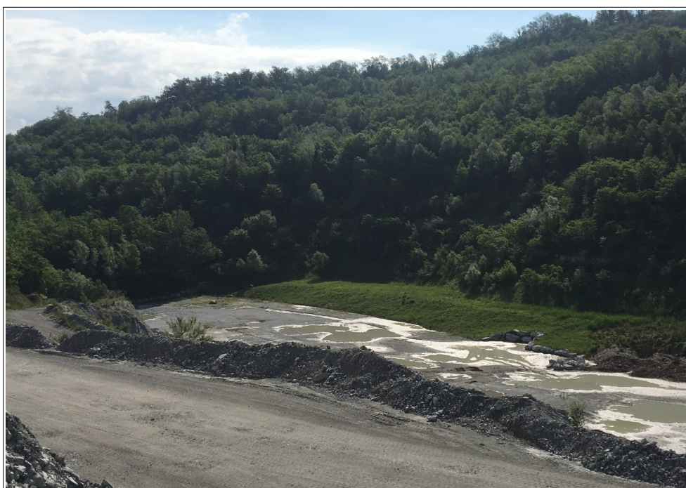
Figura 13 - Vista panoramica del gradone rinverdito con idrosemina durante l'autunno 2017 (immagine del 07.06.2019). La copertura erbacea appare essere continua e in buona salute.
