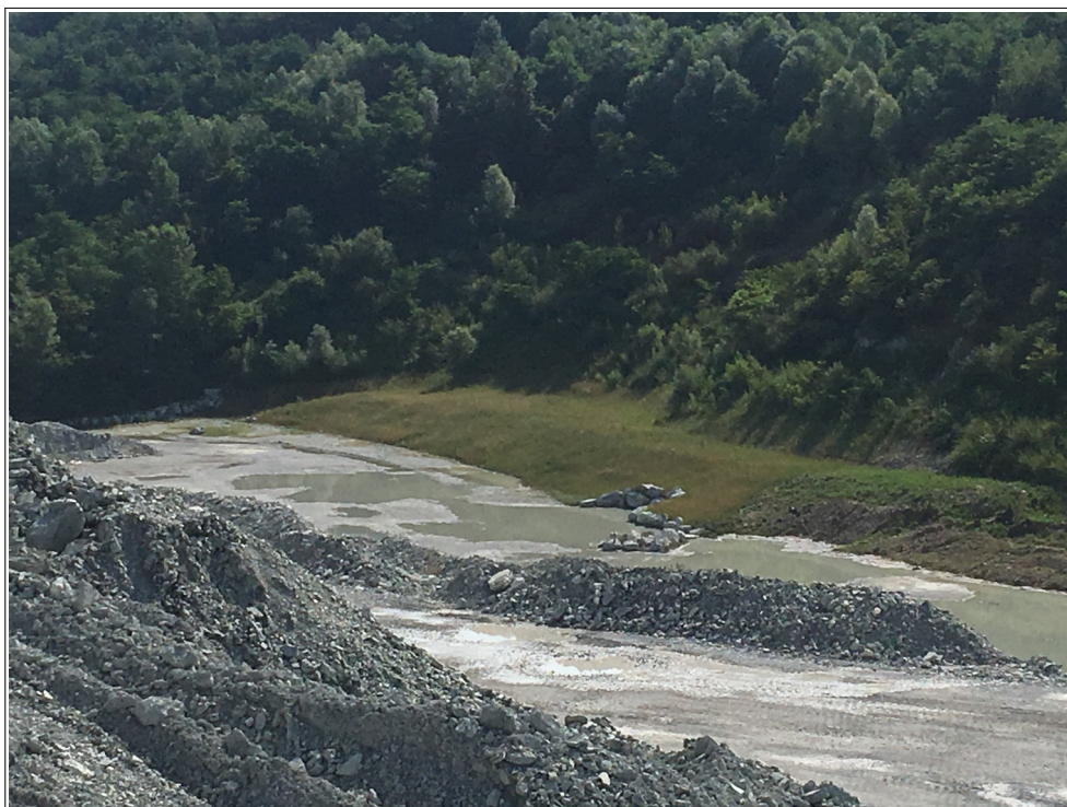
Figura 8 - Vista del gradone rinverdito con idrosemina durante l'autunno 2017 che prosegue verso la destra dell'immagine con operazioni di sistemazione morfologica da sottoporre successivamente a rinverdimento (immagine del 09.07.2018).
