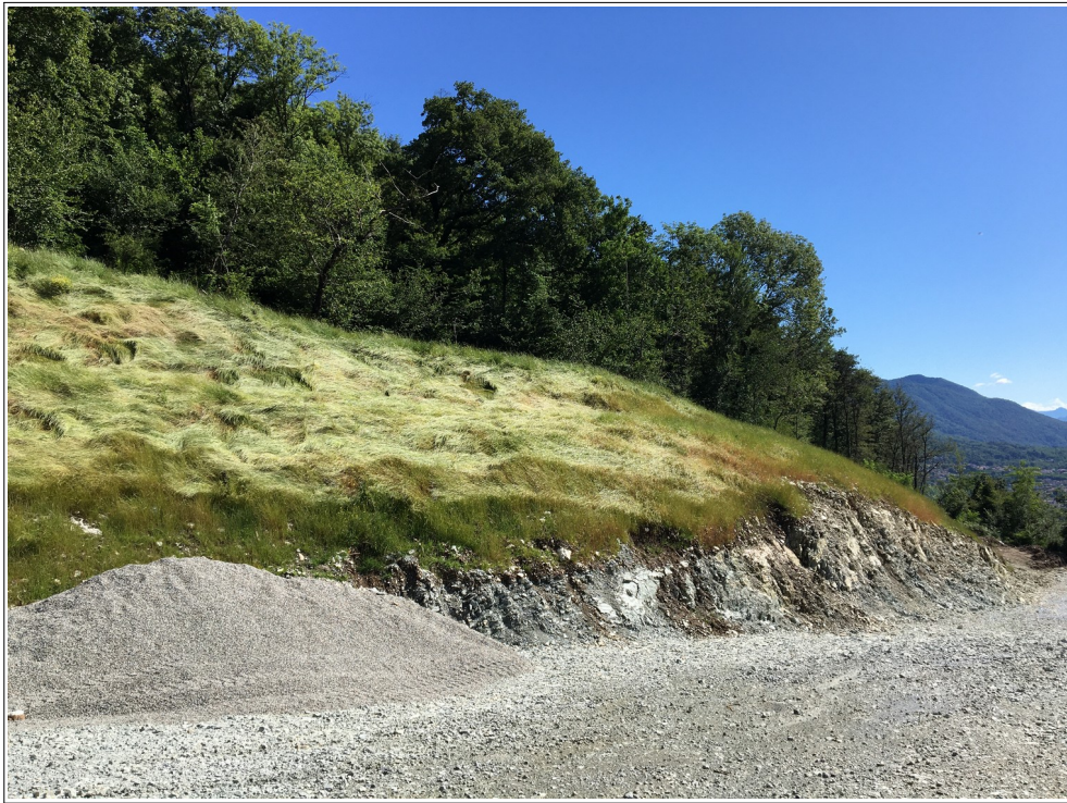
Figura 16 - Vista di una delle porzioni rinverdate con idrosemina durante l'autunno 2019 (immagine del 05.06.2020).
