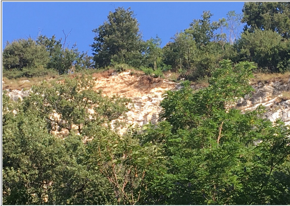
Figura 21 – Vista dell'area della figura 19 dalla quale si sarebbero staccati i massi secondo la segnalazione pervenuta da un cittadino al Comune di Caravate, vista dal piazzale della Chiesa Parrocchiale (foto del 01.09.2017).
