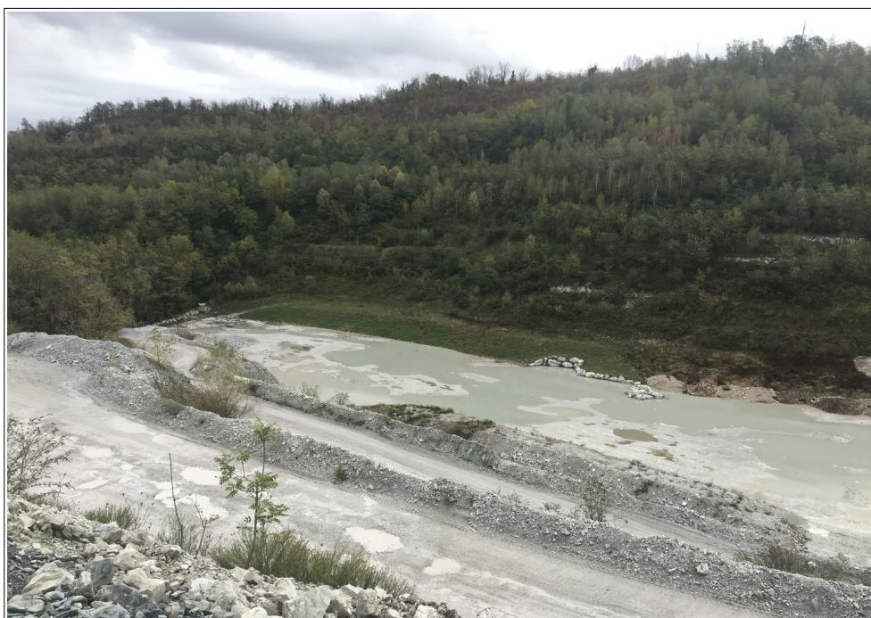
Figura 12 - Vista panoramica del gradone rinverdito con idrosemina durante l'autunno 2017 (immagine del 02.11.2018). La copertura erbacea appare essere continua e in buona salute.
