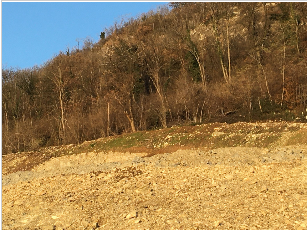
Figura 14 - Vista panoramica di una delle porzioni rinverdite con idrosemina durante l'autunno 2019 (immagine del 06.12.2019). La copertura erbacea inizia a nascere.
