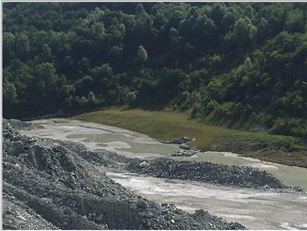
Figura 7 - Vista del gradone rinverdito con idrosemina durante l'autunno 2017 che prosegue verso la destra dell'immagine con operazioni di sistemazione morfologica da sottoporre successivamente a rinverdimento (immagine del 09.07.2018).
