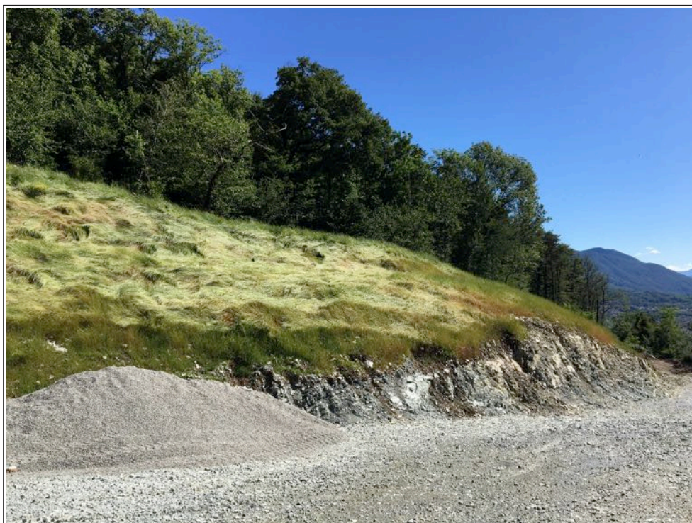
Figura 11 - Vista di una delle porzioni rinverdate con idrosemina durante l'autunno 2019 (immagine del 05.06.2020).
