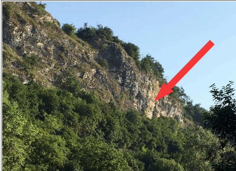
Figura 16 – Area da cui si sarebbero staccati i massi secondo la segnalazione pervenuta, vista dal piazzale della Chiesa Parrocchiale (foto del 04.08.2017).
