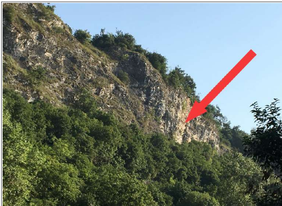
Figura 17 – Area da cui si sarebbero staccati i massi secondo la segnalazione pervenuta, vista dal piazzale della Chiesa Parrocchiale (foto del 04.08.2017).
