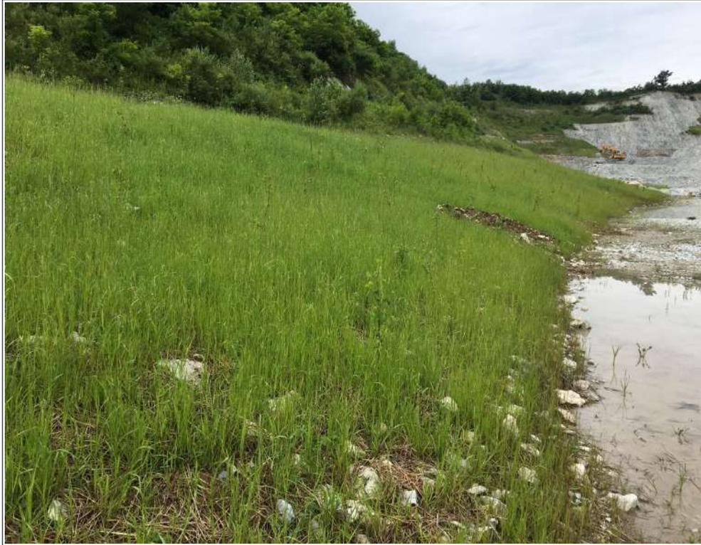
Figura 6 - Vista del gradone rinverdito con idrosemina durante l'autunno 2017 (immagine del 08.06.2018).
