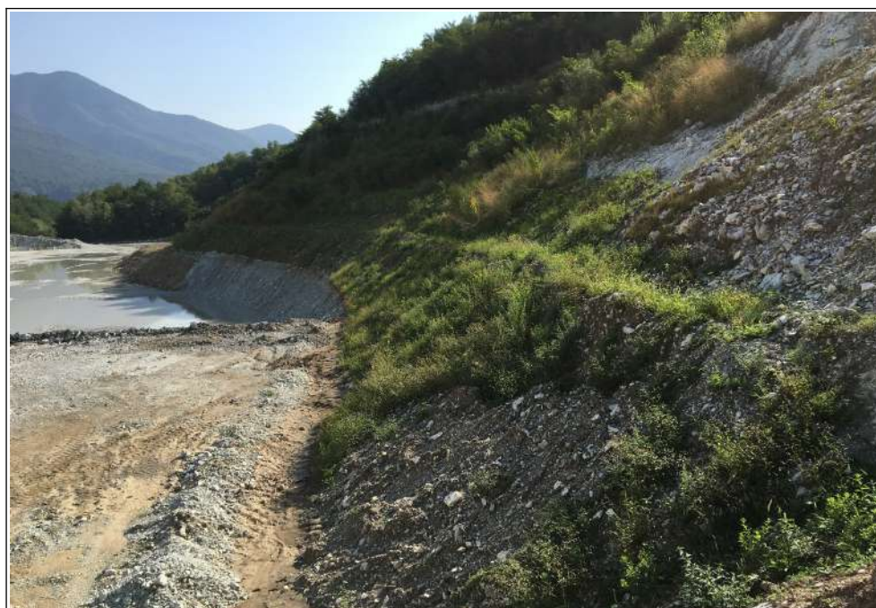
Figura 3 – Vista dell'area in cui è avvenuto il recupero ambientale (immagine del 04.08.2017). Si noti come lo sviluppo del recupero sia maggiore alla quota più alta e come diminuisca progressivamente verso il basso (in primo piano).
