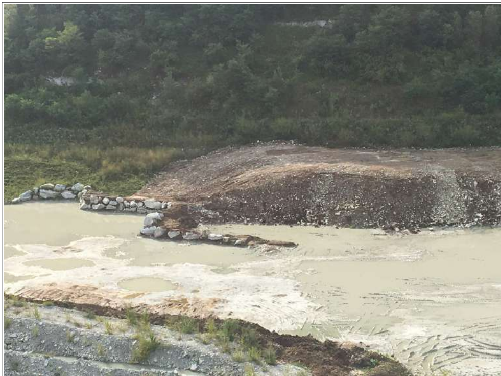
Figura 14 – Vista della fase di recupero morfologico con lo sterile di copertura (immagine del 09.08.2019).
