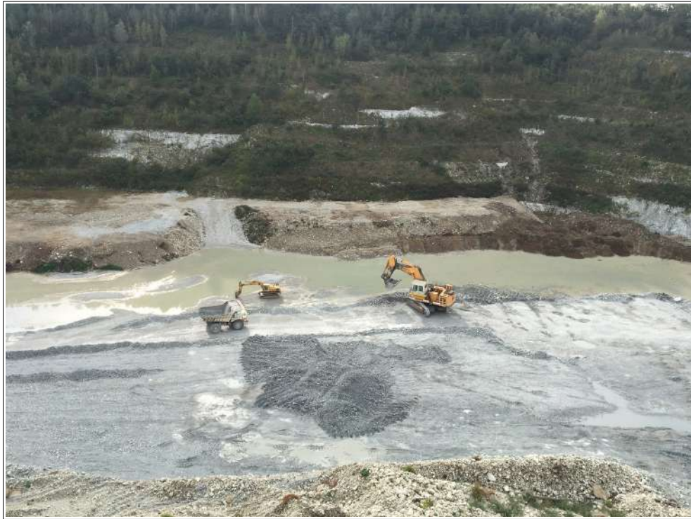
Figura 15 – Vista della fase di recupero morfologico con lo sterile di copertura (immagine del 09.10.2020).
