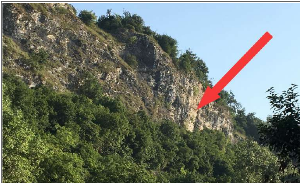
Figura 19 – Area da cui si sarebbero staccati i massi secondo la segnalazione pervenuta, vista dal piazzale della Chiesa Parrocchiale (foto del 04.08.2017).
