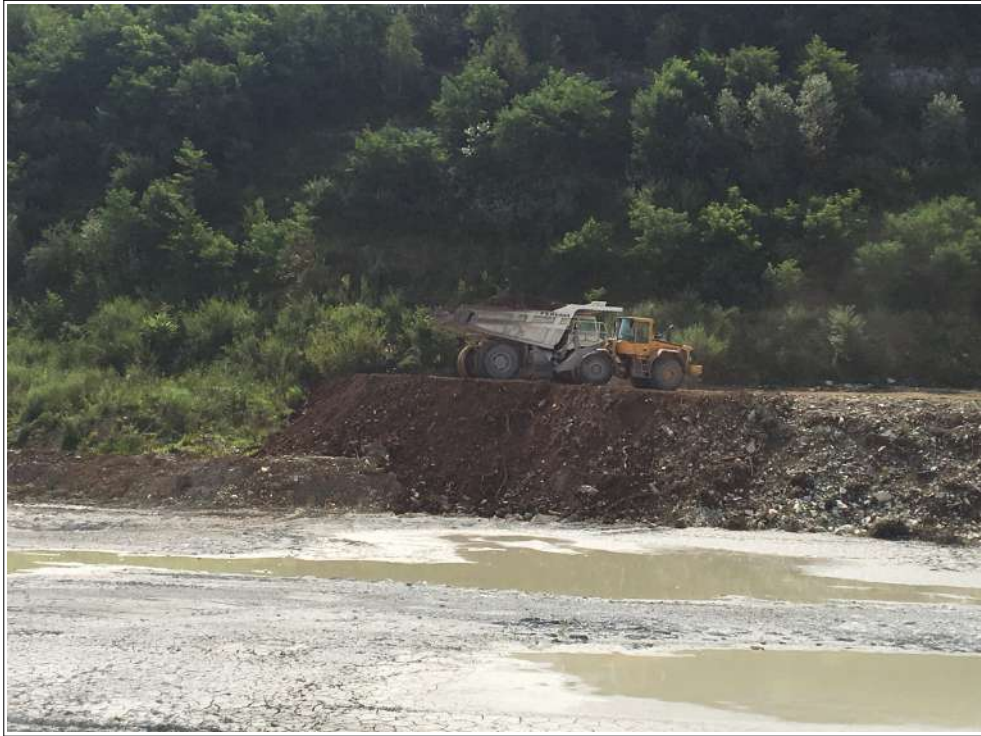
Figura 13 – Vista della fase di recupero morfologico messa in campo con il dumper che trasporta lo sterile di copertura e la pala gommata che lo distende (immagine del 03.07.2019).
