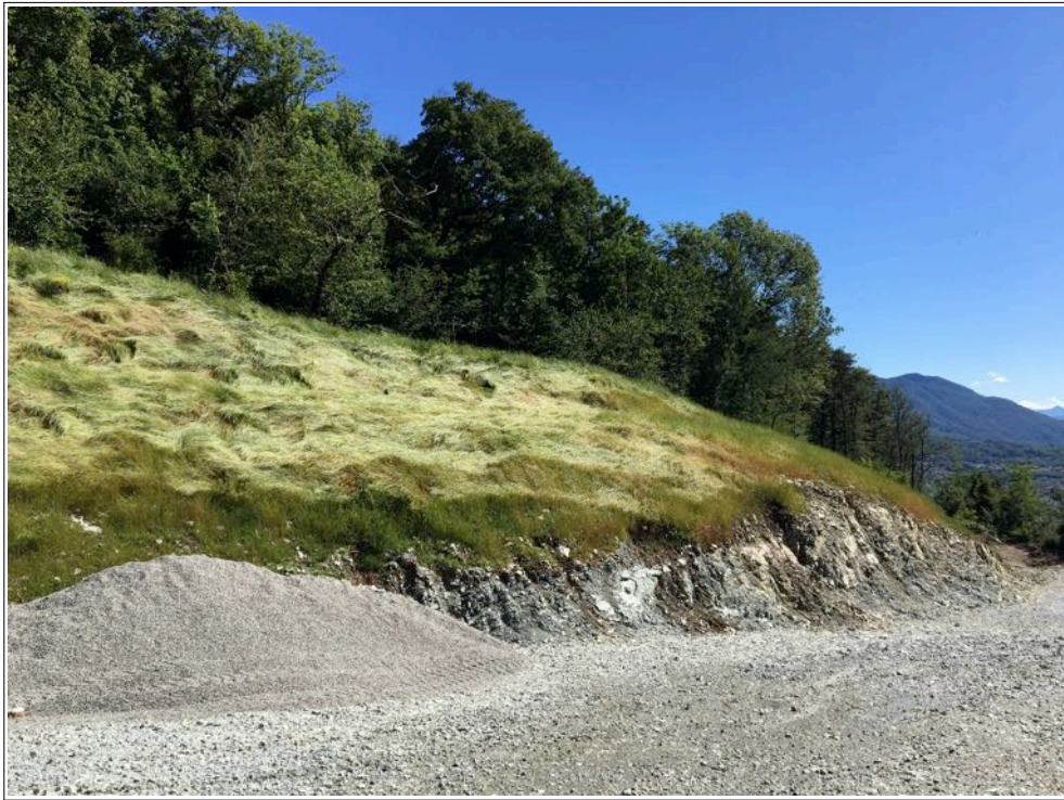
Figura 11 - Vista di una delle porzioni rinverdite con idrosemina durante l'autunno 2019 (immagine del 05.06.2020).
