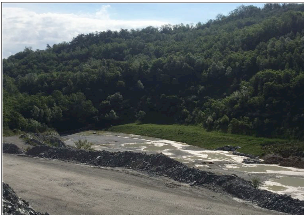
Figura 9 - Vista panoramica del gradone rinverdito con idrosemina durante l'autunno 2017 (immagine del 07.06.2019). La copertura erbacea appare essere continua e in buona salute.
