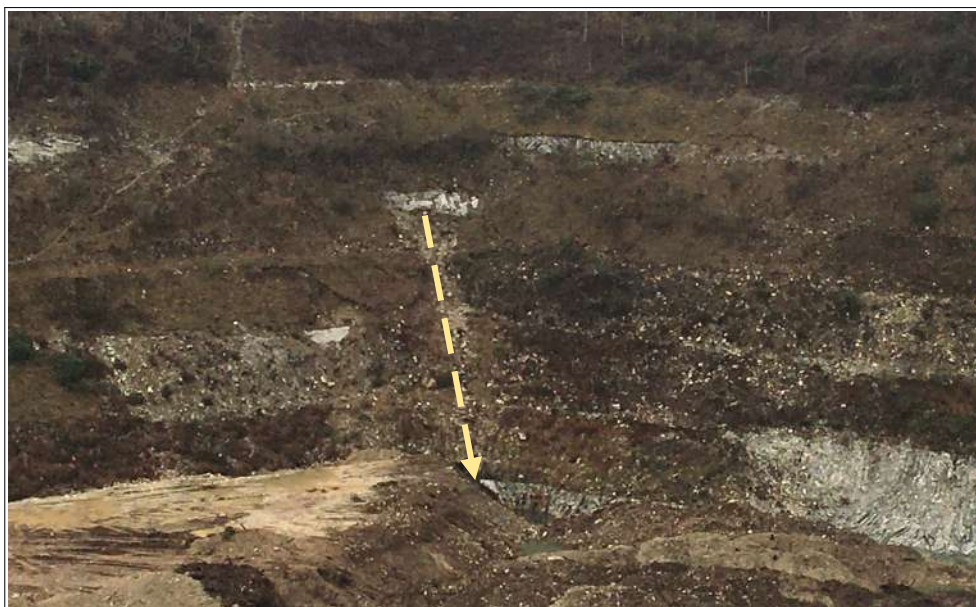
Figura 18 - Il solco d'erosione (freccia di colore giallo) da sistemare con tecniche di ingegneria naturalistica
