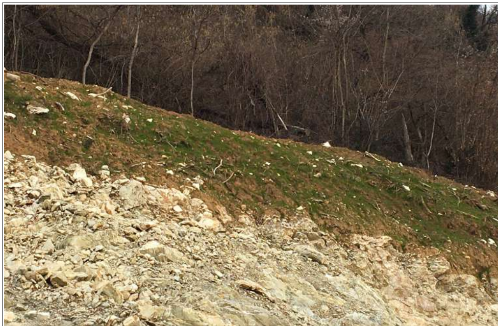
Figura 10 - Vista di una delle porzioni di scarpata che sono state rinverdate con idrosemina durante l'autunno 2019 (immagine del 07.01.2020).
