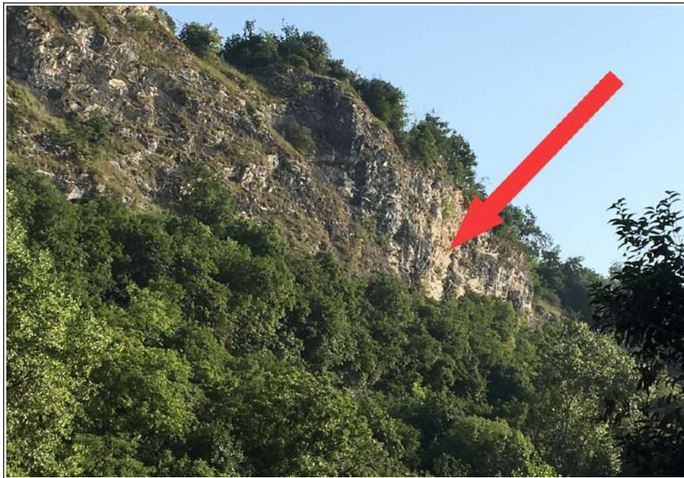
Figura 20 – Area da cui si sarebbero staccati i massi secondo la segnalazione pervenuta, vista dal piazzale della Chiesa Parrocchiale (foto del 04.08.2017).
