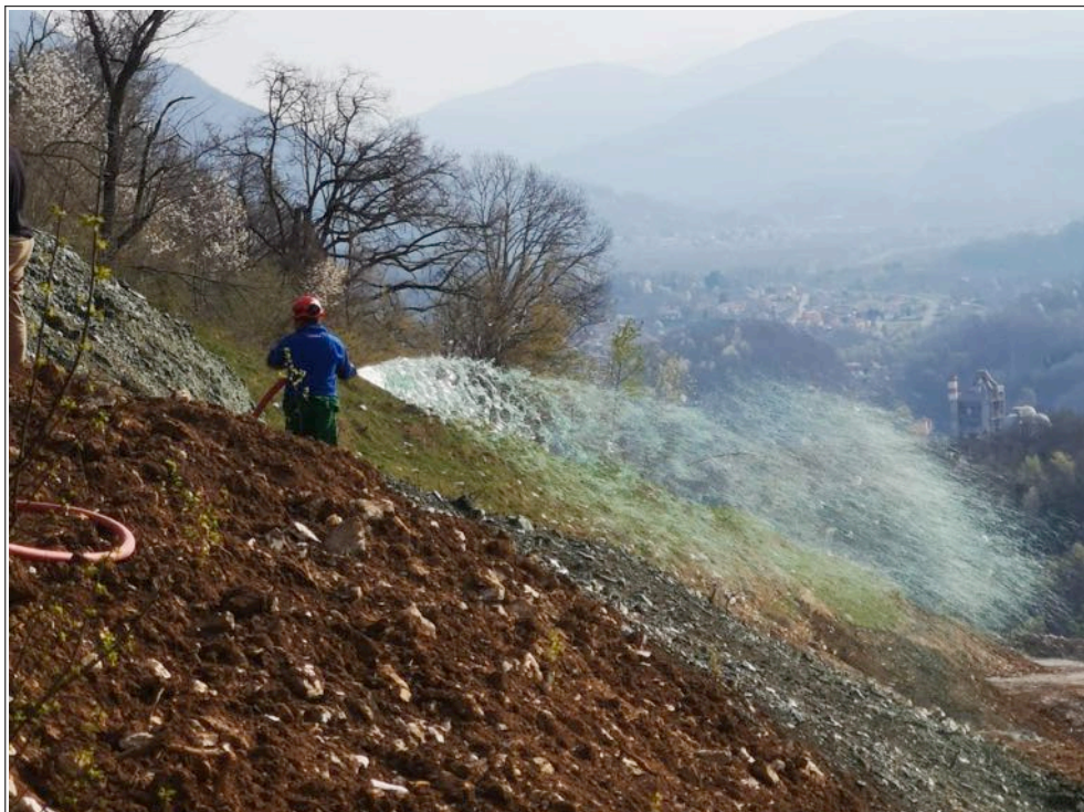
Figura 20 - Svolgimento dell'attività di idrosemina dell'aprile 2021 (foto gentilmente fornita dal geom. Giampiero Borin).
