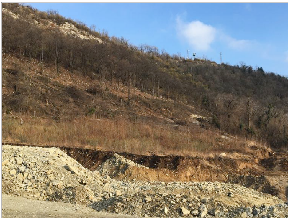
Figura 13 – Vista panoramica di una porzione dell'area in cui è stato tagliato il bosco per procedere ai lavori preparatori alla coltivazione (immagine del 02.03.2019).
