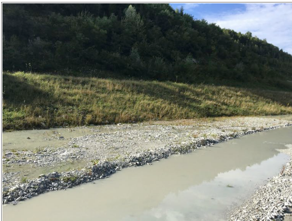
Figura 11 – Vista del gradone rinverdito con idrosemina durante l'autunno 2017 (immagine del 03.09.2018). La copertura erbacea appare essere continua e in buona salute.
