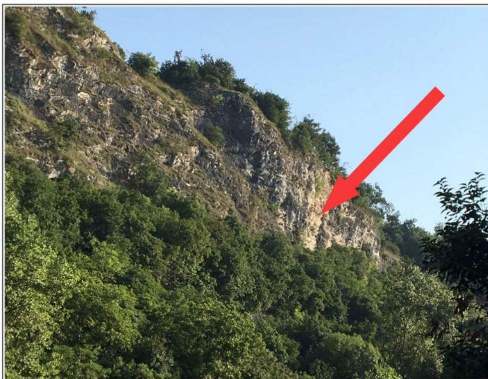
Figura 14 – Vista dell'area (indicata dalla freccia di colore rosso) dalla quale si sarebbero staccati i massi secondo la segnalazione pervenuta da parte di un cittadino al Comune vista dal piazzale della Chiesa Parrocchiale (foto del 04.08.2017).
