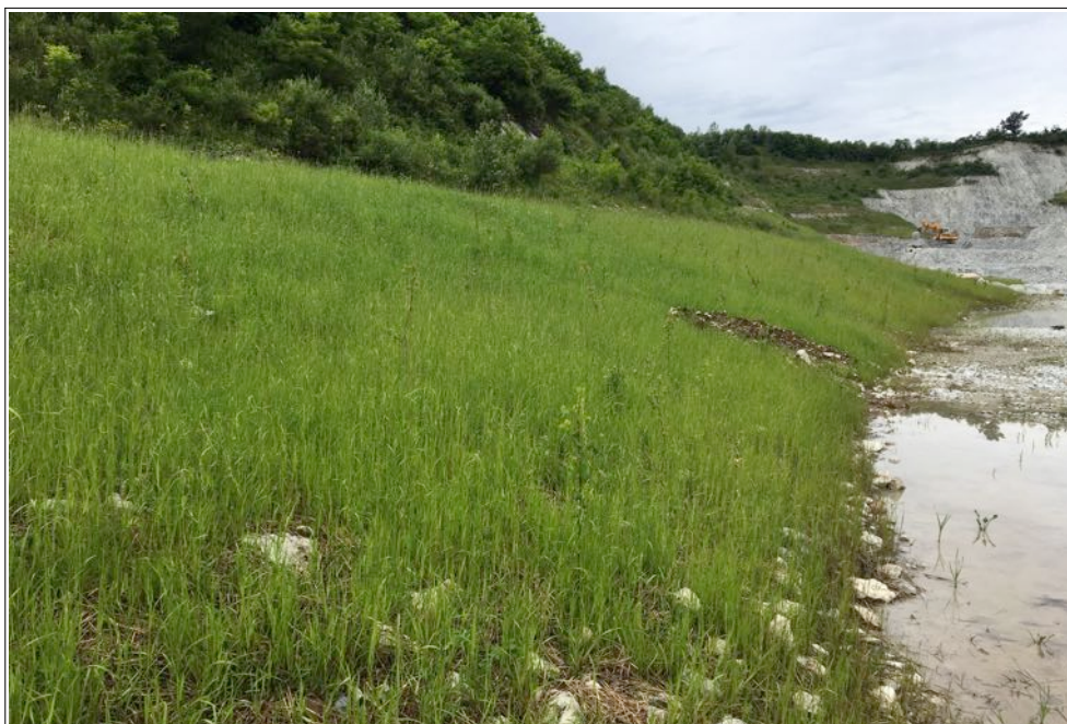
Figura 7 – Vista del gradone rinverdito con idrosemina durante l'autunno 2017 (immagine del 08.06.2018).
