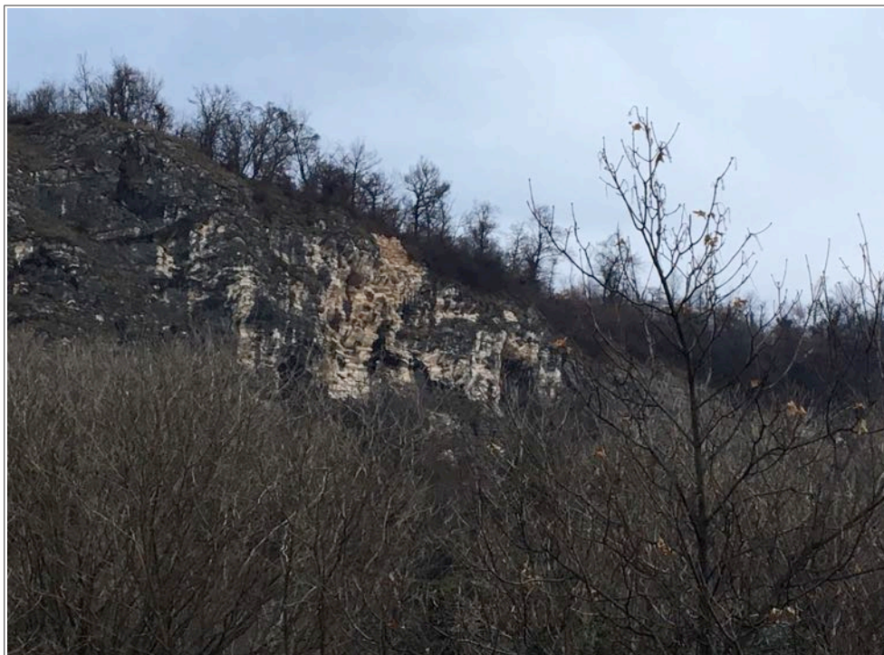
Figura 16 – Vista della medesima area della figura 12 dalla quale si sarebbero staccati i massi secondo la segnalazione pervenuta al Comune di Caravate nell'estate 2017, vista dal piazzale antistante la Chiesa parrocchiale (foto del 09/02/2018).
