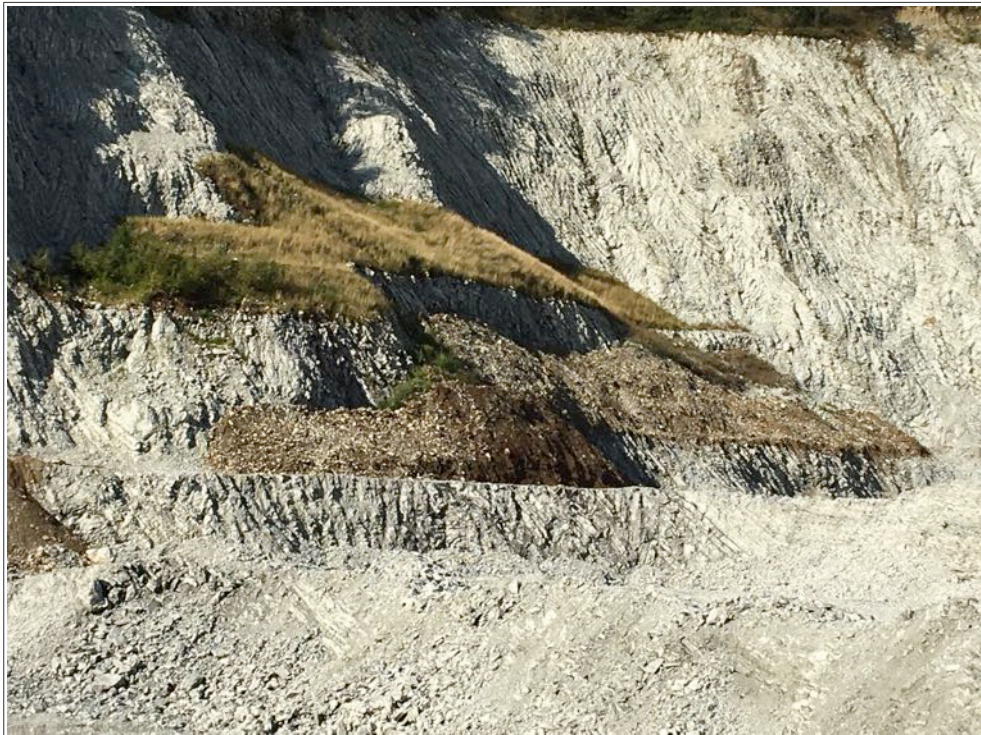
Figura 10 – Vista della zona in cui sono in corso le attività di recupero morfologico da sottoporre a quelle di recupero vegetazionale nel prossimo autunno (immagine del 03.09.2018).
