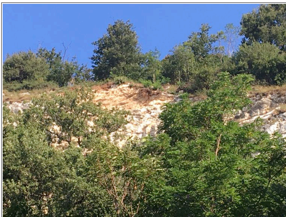
Figura 14 – Vista dell'area della figura 12 dalla quale si sarebbero staccati i massi secondo la segnalazione pervenuta da un cittadino al Comune di Caravate, vista dal piazzale della Chiesa Parrocchiale (foto del 01/09/2017).
