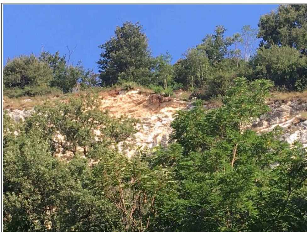
Figura 12 – Vista dell'area della figura 10 dalla quale si sarebbero staccati i massi secondo la segnalazione pervenuta da un cittadino al Comune di Caravate, vista dal piazzale della Chiesa Parrocchiale (foto del 01/09/2017).
