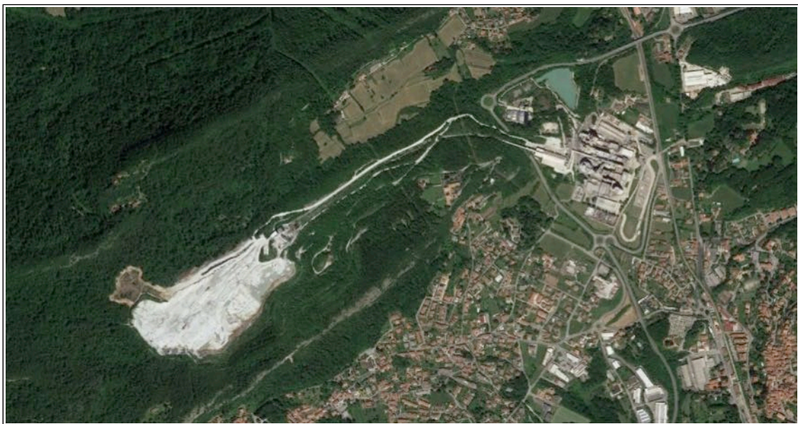
Figura 1 – Nell'immagine del 21 maggio 2017 estratta dal software Google Earth Pro si può osservare la Miniera di Sasso Poiano a ovest, la cementeria a est e il paese di Caravate a sud. Tra il paese e la miniera si può osservare una sottile linea di colore marrone chiaro che è la parete litoide che sovrasta l'abitato e che a volte determina crolli di frammenti rocciosi.
