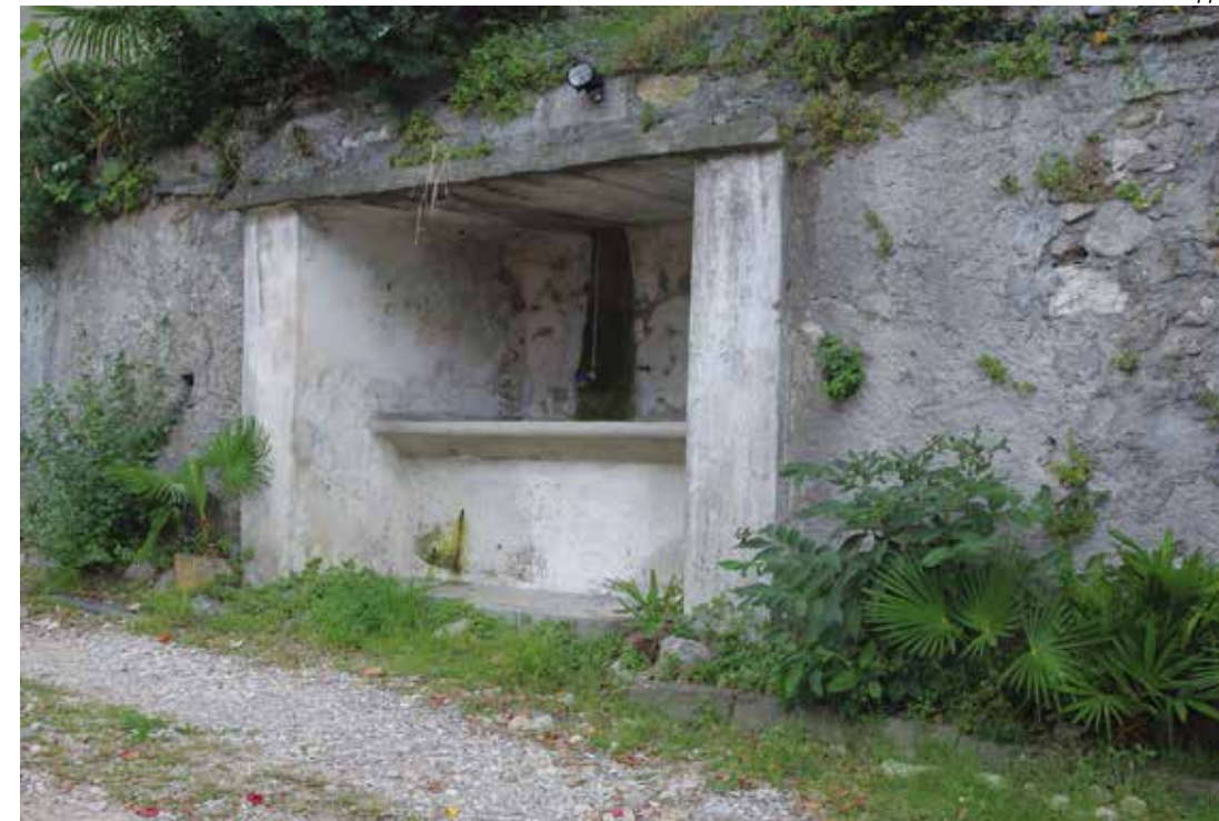
Veduta del lavatoio di Via Monte Grappa
