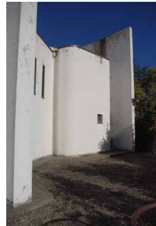
Veduta del lato meridionale della Chiesa
