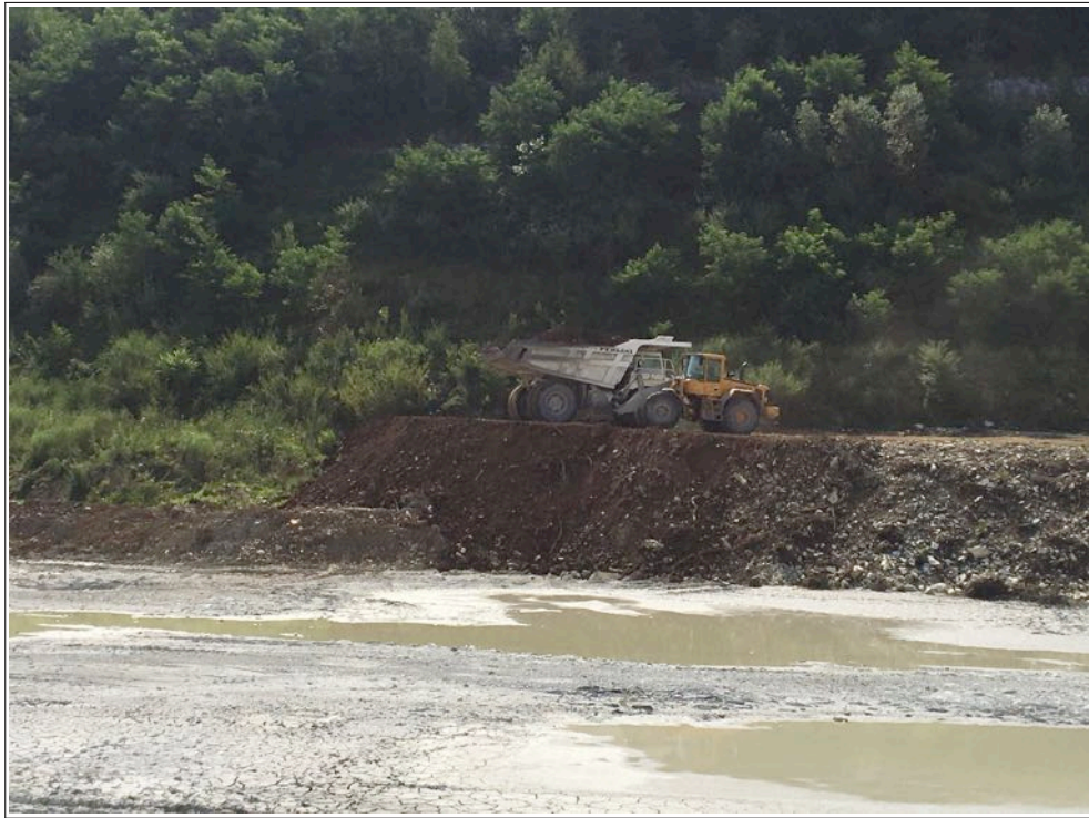
Figura 16 – Vista della fase di recupero morfologico messa in campo con il dumper che trasporta lo sterile di copertura e la pala gommata che lo distende (immagine del 03.07.2019).
