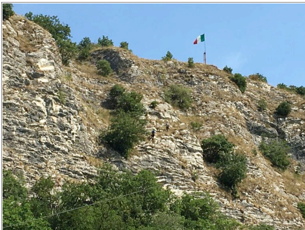
Figura 26 – Vista della parete rocciosa di Sasso Poiano durante le operazioni di disgaggio (foto del giorno 03.07.2019).
