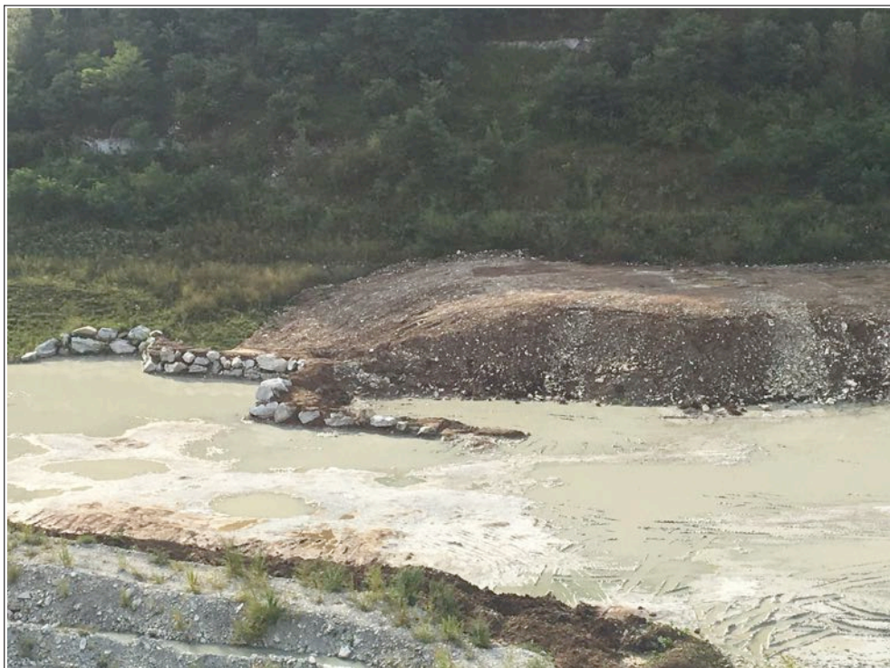
Figura 17 – Vista della fase di recupero morfologico con lo sterile di copertura (immagine del 09.08.2019).
